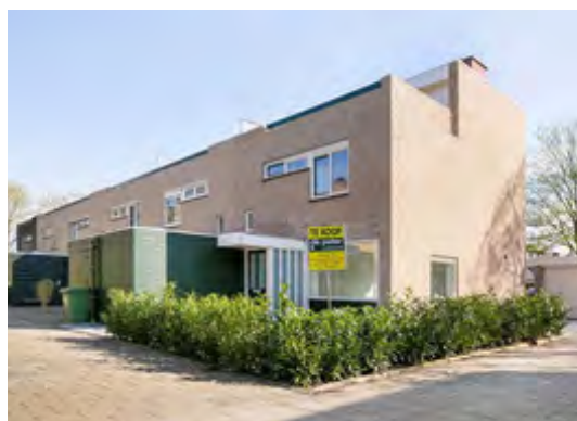
Na de renovatie
