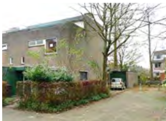
Voor de renovatie
