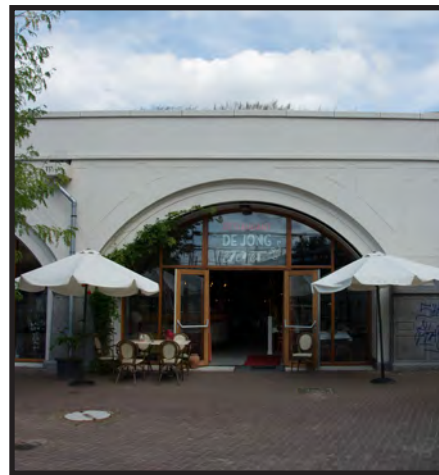
3. Het voormalige Hofpleinspoorviaduct. Nu de Hofbogen met verschillende ondernemers.
