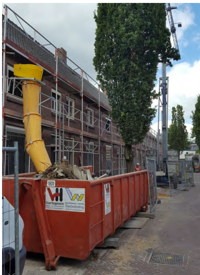
Werkzaamheden in het Philipsdorp.
