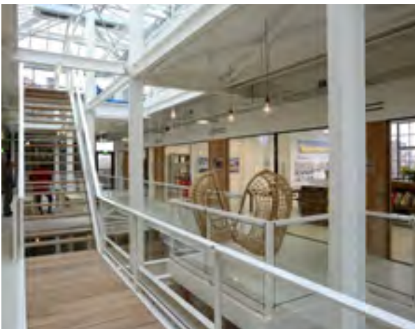
Het atrium en werkruimtes na renovatie
