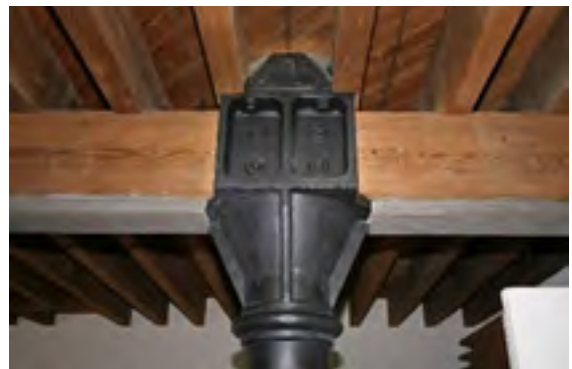
Gietijzeren kolom met beton
